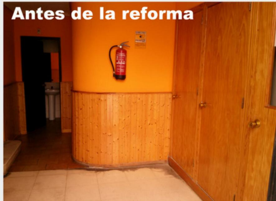
Los aseos se encuentran en un estado lamentable de conservación, con el alicatado desprendido, los muros hinchados en sus arranques, las cabinas muy estrechas y sin ventilación exterior.
